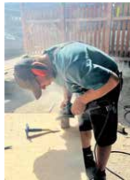
Bevor der Baum gepflanzt werden konnte, mussten die Zimmerer-Azubis erstmal Pflaster abnehmen und neu zuschneiden.
